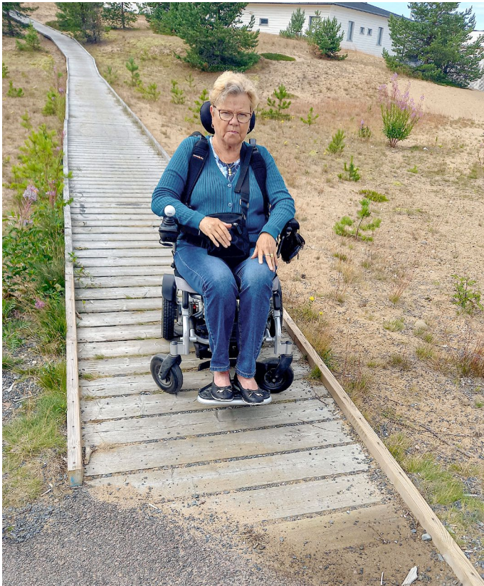
Esteetöntä, katettua reittiä Kalajoen kauniilla hiekkarannalla testamassa kesällä 2024. Routa oli kallistanut osan reitistä sähköpyörätuolilla kulkijalle vaaralliseksi.
